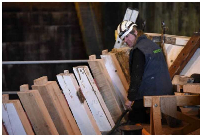
Pour remplacer les bordés de préceinte, la coque est dénudée.
