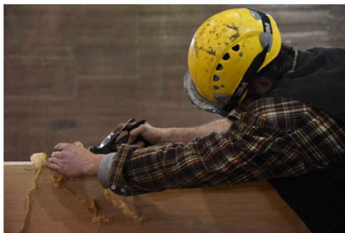
Le chêne des bordés neufs est déligné par les charpentiers du chantier.
