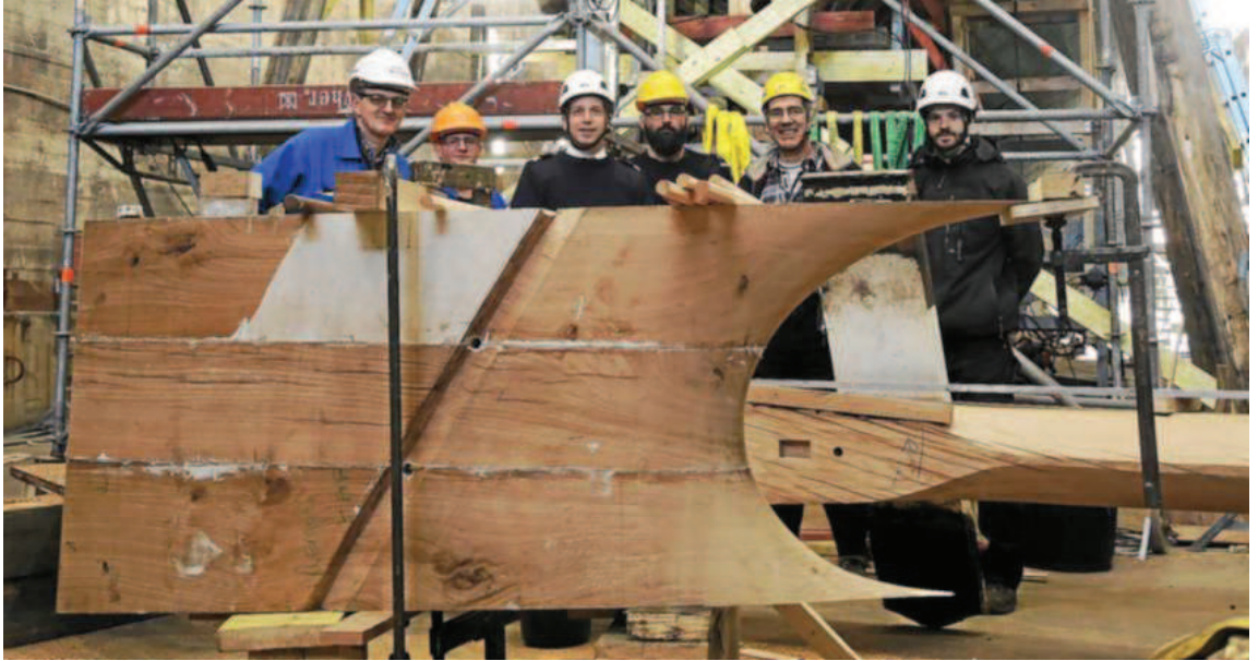
Une des pièces qui prendront place dans la reconstruction de la voute du navire.
