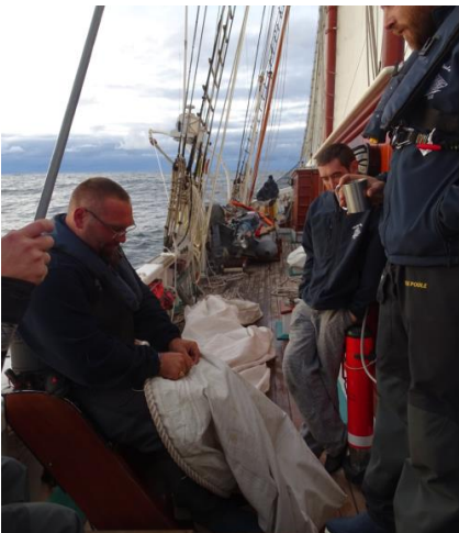
Sébastien s'affaire à la réparation de l'étai qui a souffert des dernières colères du ciel.
