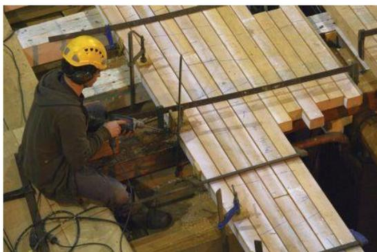
Un plan de pont a été réalisé au préalable permettant de visualiser toutes les lattes. Chaque élément a été ainsi repéré, numéroté et découpé aux dimensions voulues en avance. Une fois cette phase terminée, les lattes du pont ont été entreposées dans le bassin de la base sous-marine quinze jours avant le début des travaux afin que ces dernières s'adaptent aux conditions hygrométriques du lieu.
