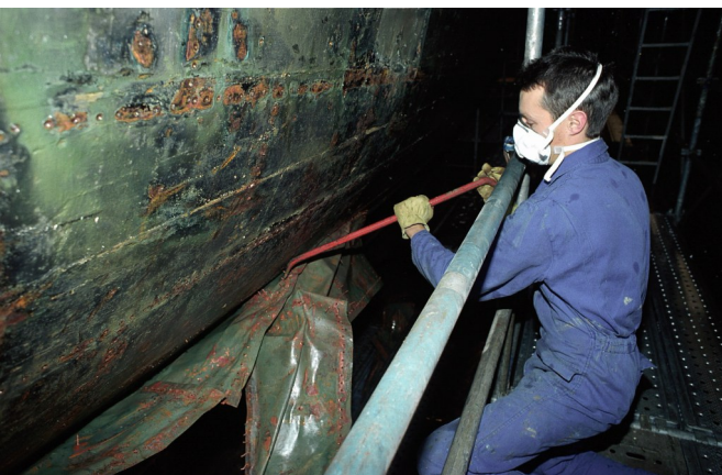
Plaques de cuivre qui recouvrent les œuvres vives
