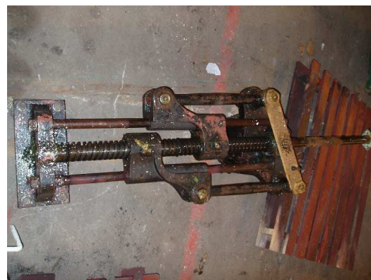
Mécanisme de barre déposé
